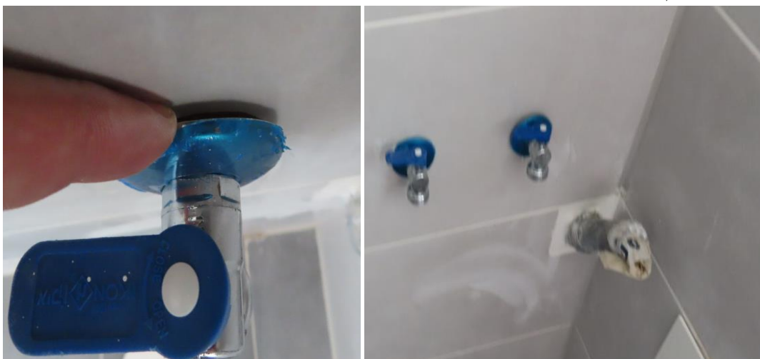
התיקון הנדרש : להשלים אטימה כנדרש ובאופן מקצועי.
